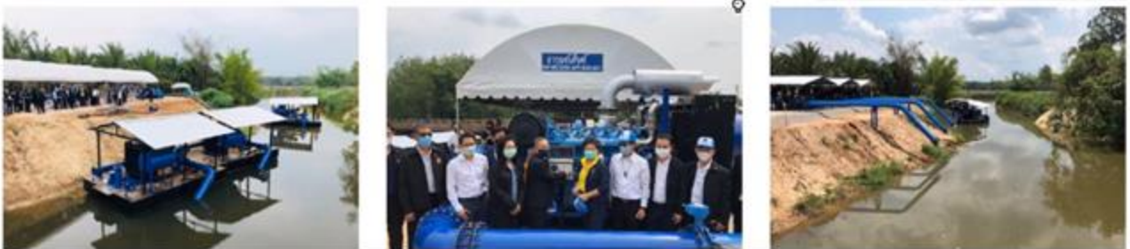
โครงการผันน้ำคลองสะพานเดิมอ่างเก็บน้ำประแสร์
